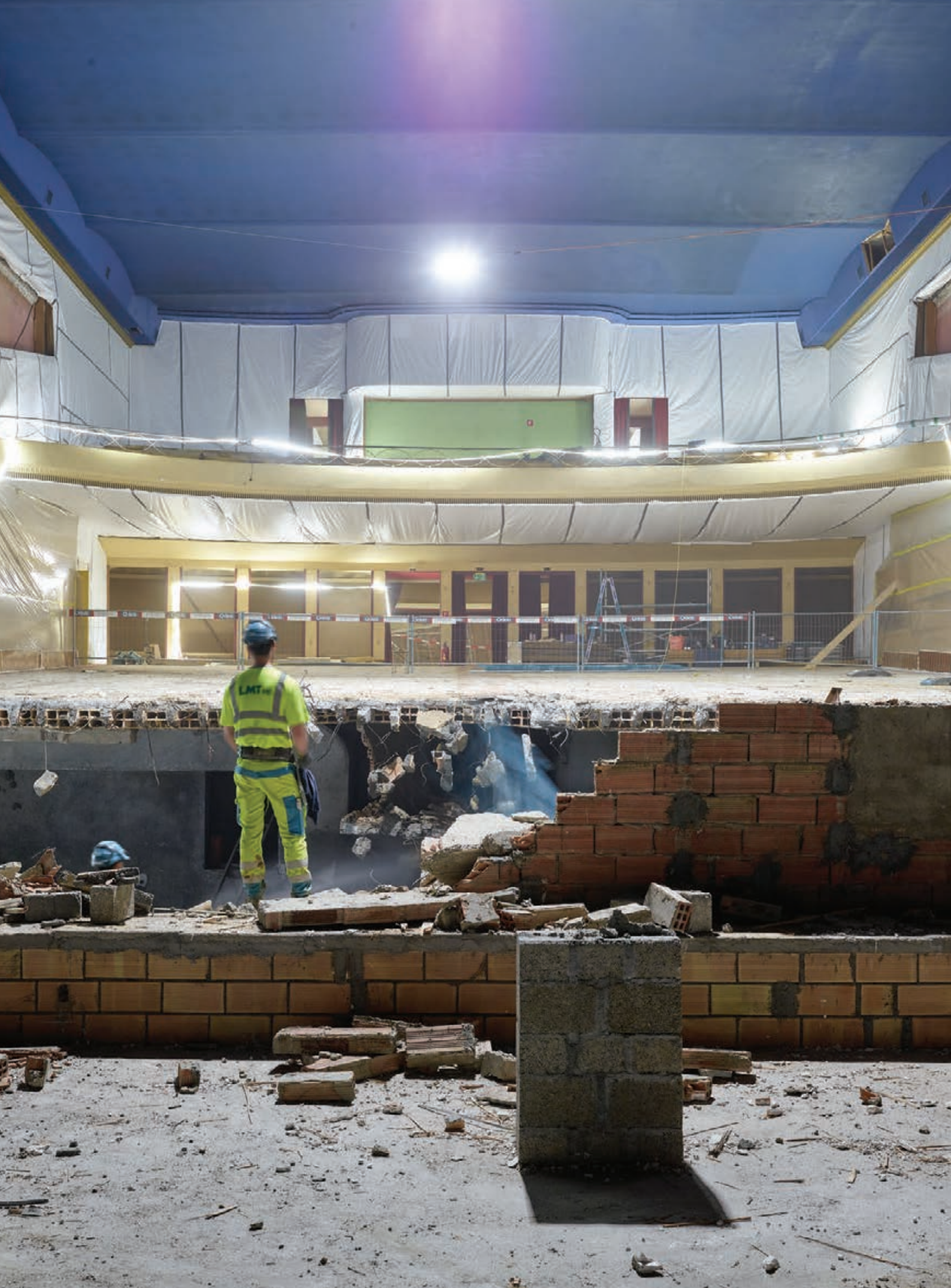
Chantier du cinéma Capitole à Lausanne, future «Maison du cinéma».
